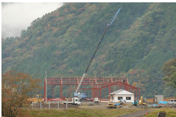
【大字林地区に建設中の木材加工施設】
